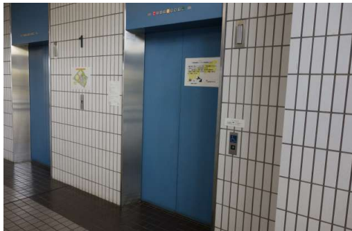
エレベータ 1号館正門側
