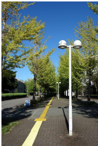
点字ブロック 正門～1号館入口
