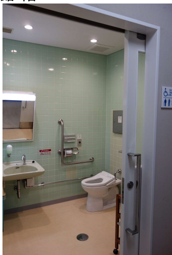
多目的トイレ 1号館2階
