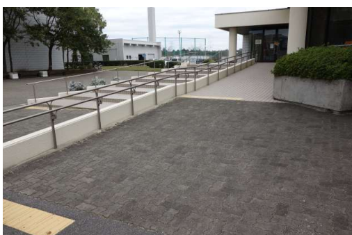
スロープ 2号館
